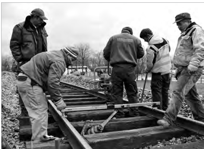
Neue Schwellen für das Museumsgleis
