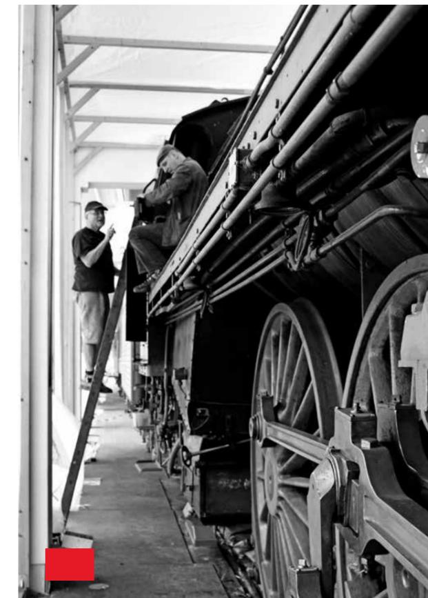
**Restaurierung der Dampflokomotive 18 316 mit ehrenamtlicher Unterstützung**
